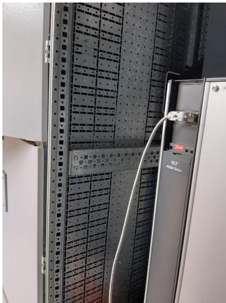
Figura 1 – Barreira física entre o compartimento da UTR, compartimento de entrada de energia e das unidades operacionais.
