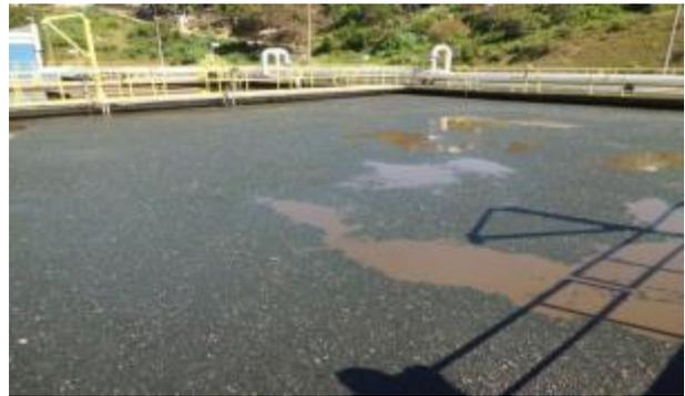
Figura 20: Início do tratamento: tanque anóxico (entrada submersa)
