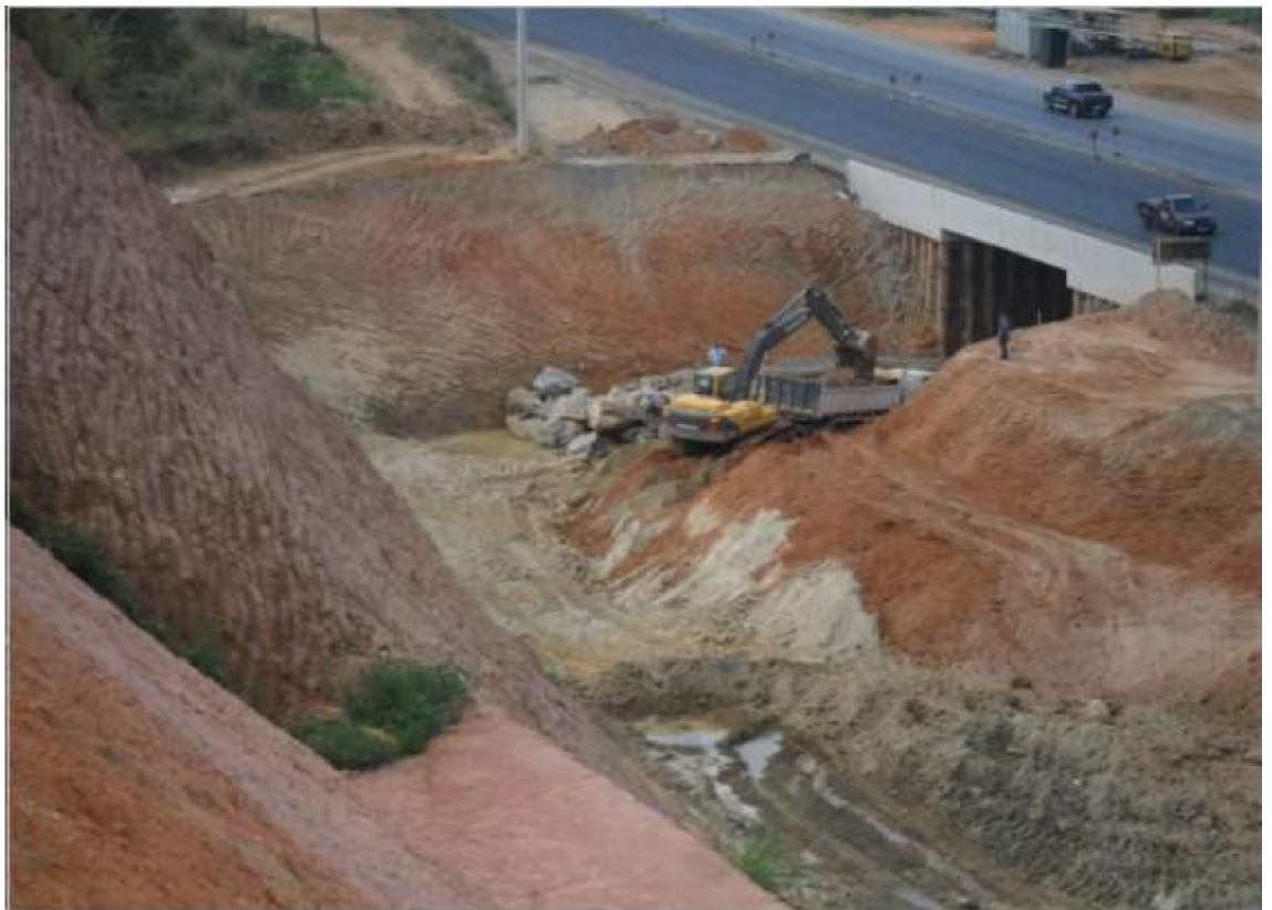
Foto das obras na KM292,00+480, Rodovia BR-101/ES — Contorno de Vitória.
